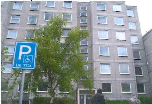
F1 Uliční pohled na budovu
